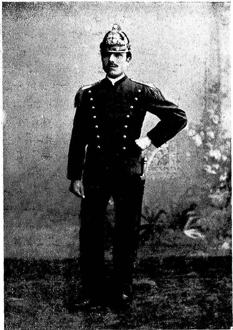
CCI - UNIFORME DEL CORPO POMPIERI DAL 1880 AL 1905 - TENUTA DI PARATA
