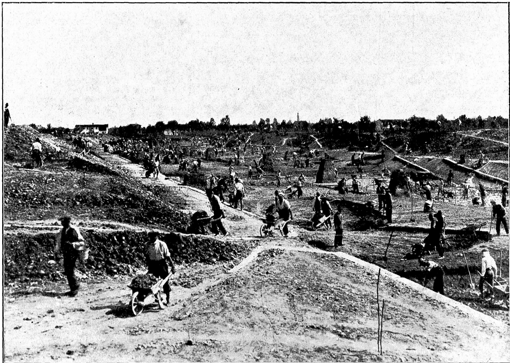
CCII - LA SISTEMAZIONE FLUVIALE NEL TERRITORIO DI PADOVA FASE DEI LAVORI DI COSTRUZIONE DEL NUOVO CANALE NAVIGABILE
