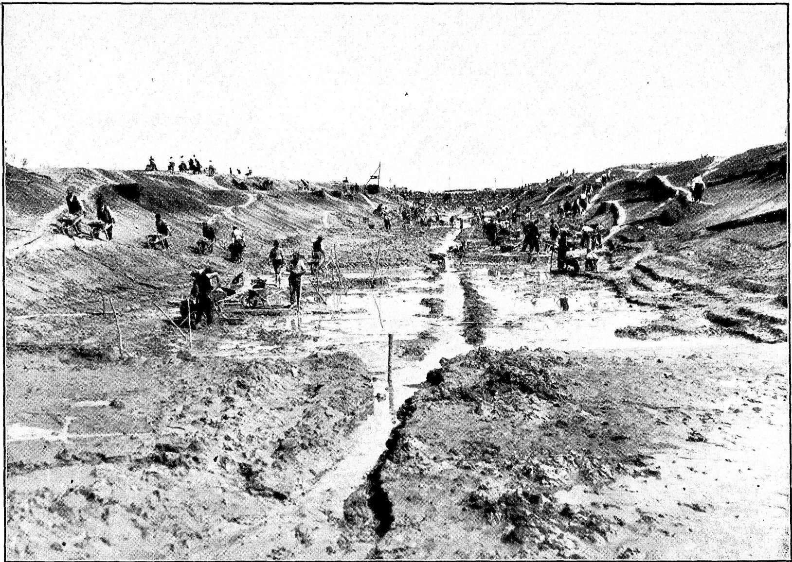
CCI - LA SISTEMAZIONE FLUVIALE NEL TERRITORIO DI PADOVA FASE DEI LAVORI DI DEVIAZIONE PROVVISORIA DEL CANALE SCARICATORE
