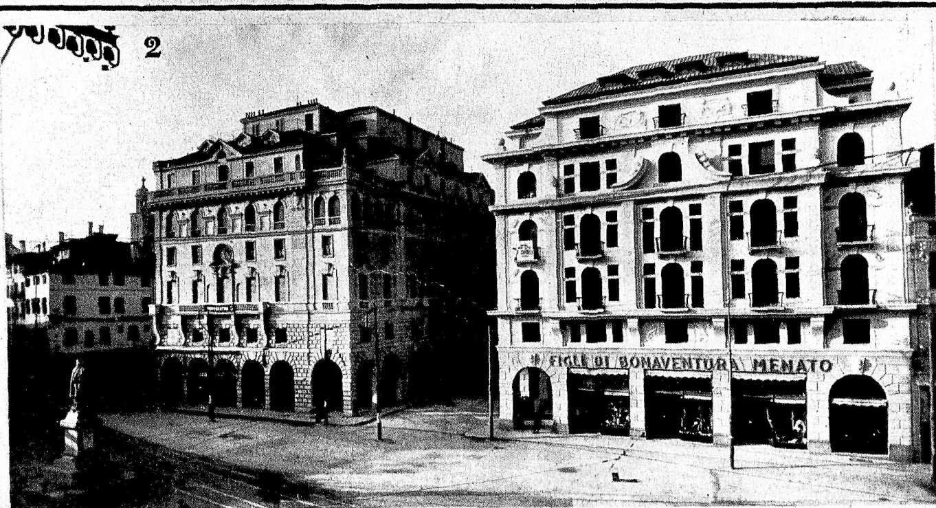
1-LA MONUMENTALE FACCIATA DEL NUOVO PALAZZO CIVICO . . . . . 2-I DUE FABBRICATI SORTI ALL'INIZIO DI UNA DELLE NUOVE VIE DEI QUARTIERI CENTRALI - VERSO PIAZZA GARIBALDI . . . . .
