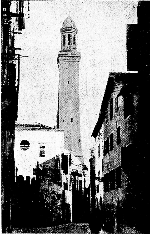
La vecchia torre universitaria demolita in parte nel 1914
