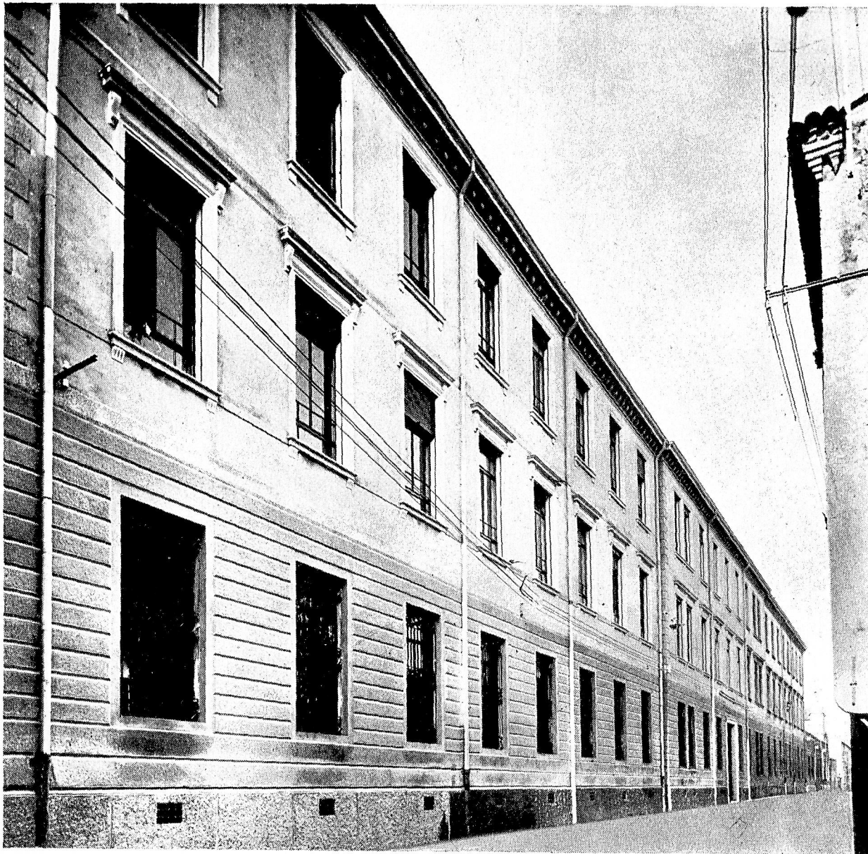
Il nuovo corpo di fabbrica della Casa di Ricovero - Facciata su Via Vendramin
