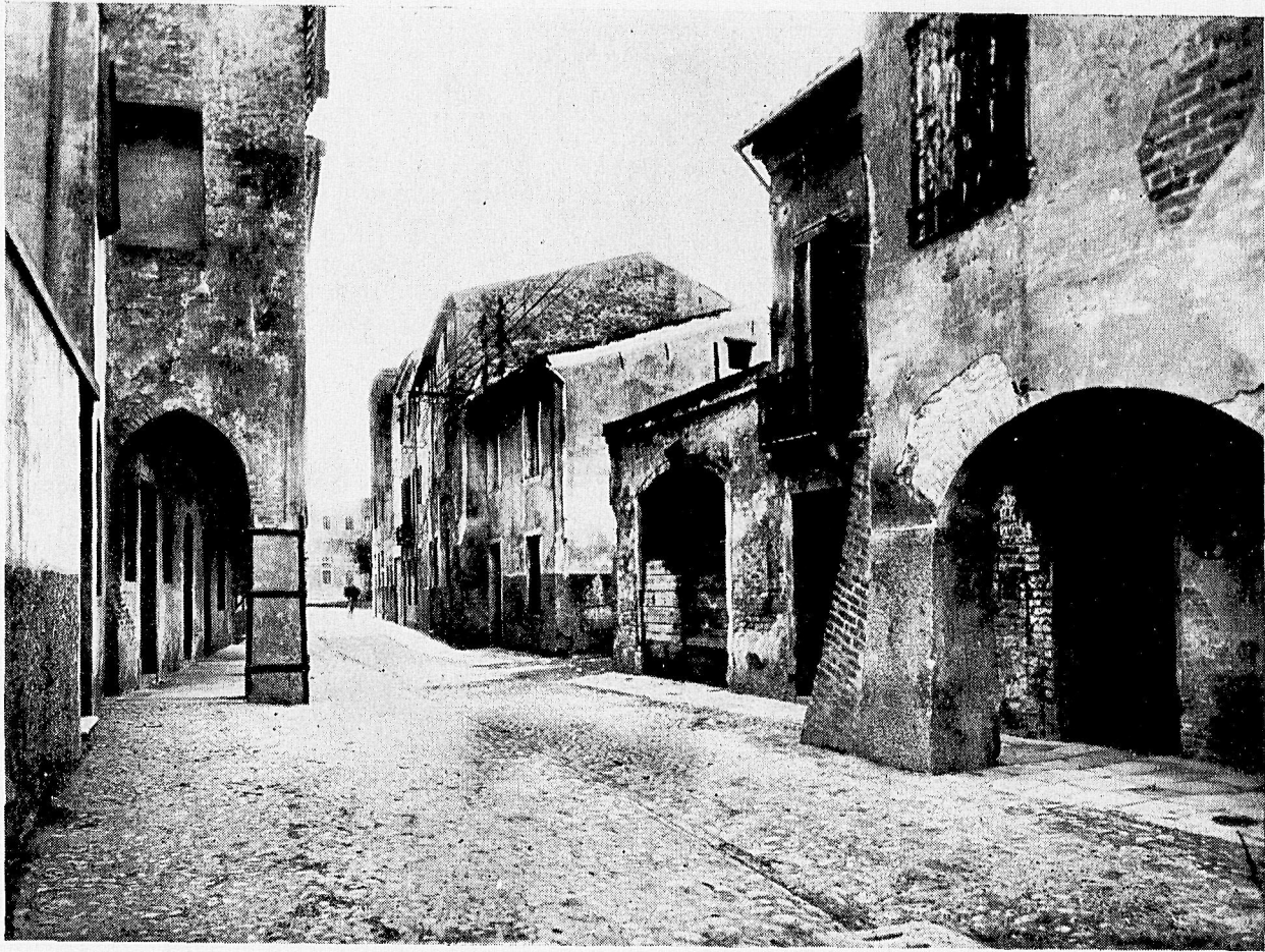
Casa di Via Vendramin demolite per la costruzione del nuovo corpo di fabbrica della Casa di Ricovero
