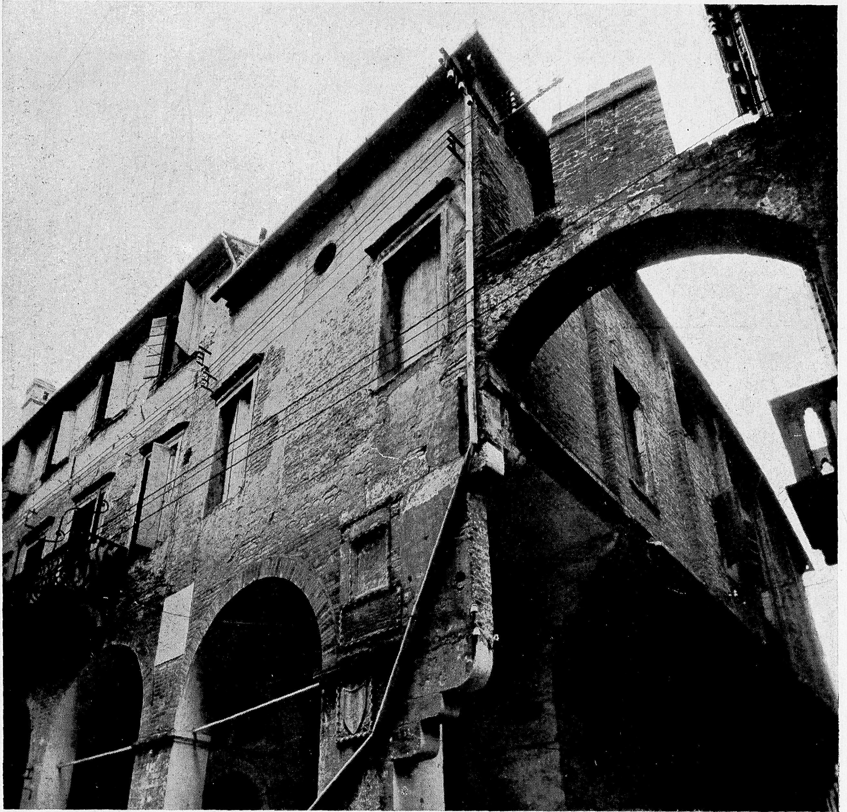
Padova - Antica casa in Via Dante
