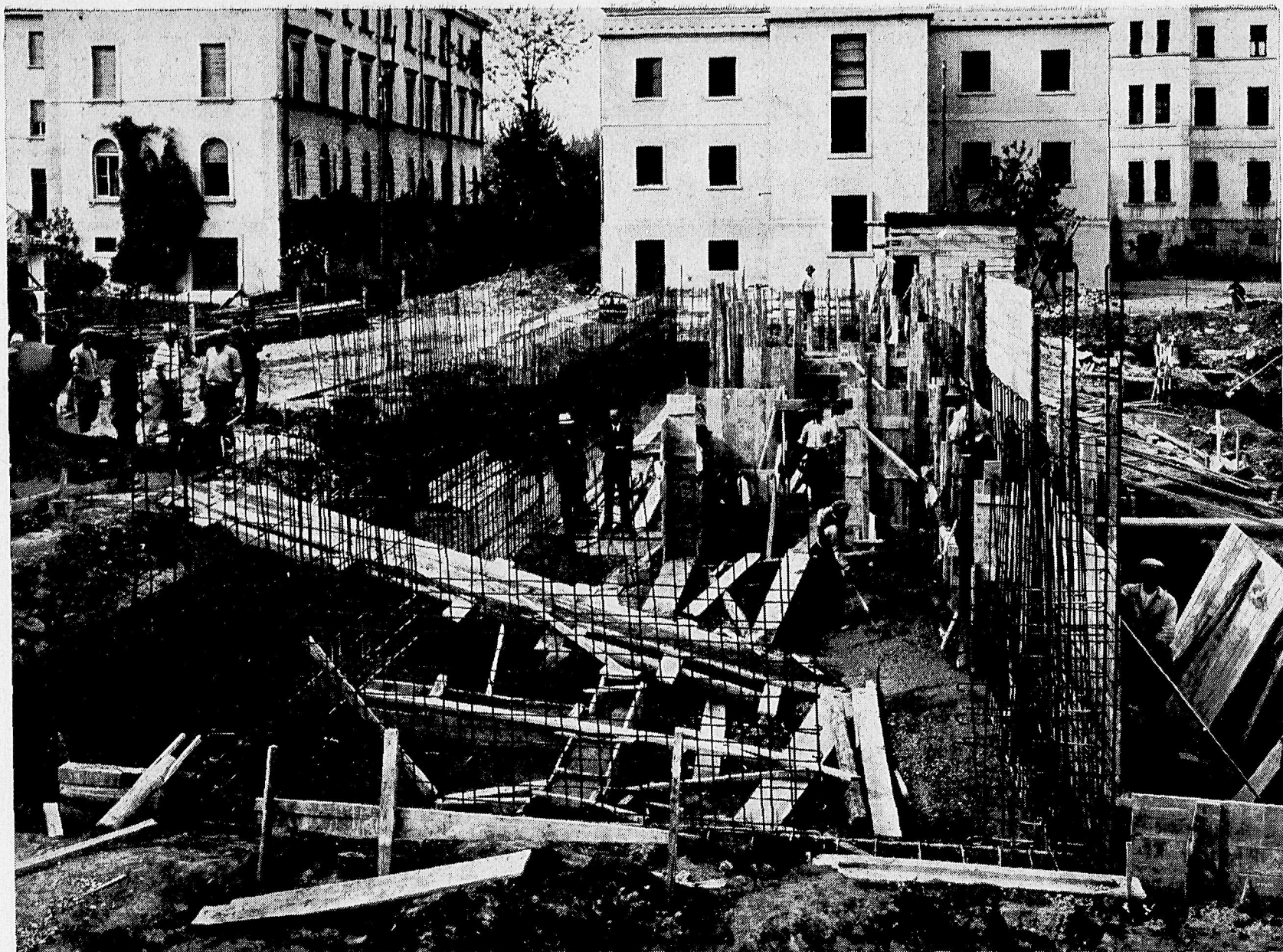
Armatura in ferro delle pareti del ricovero antiaereo
