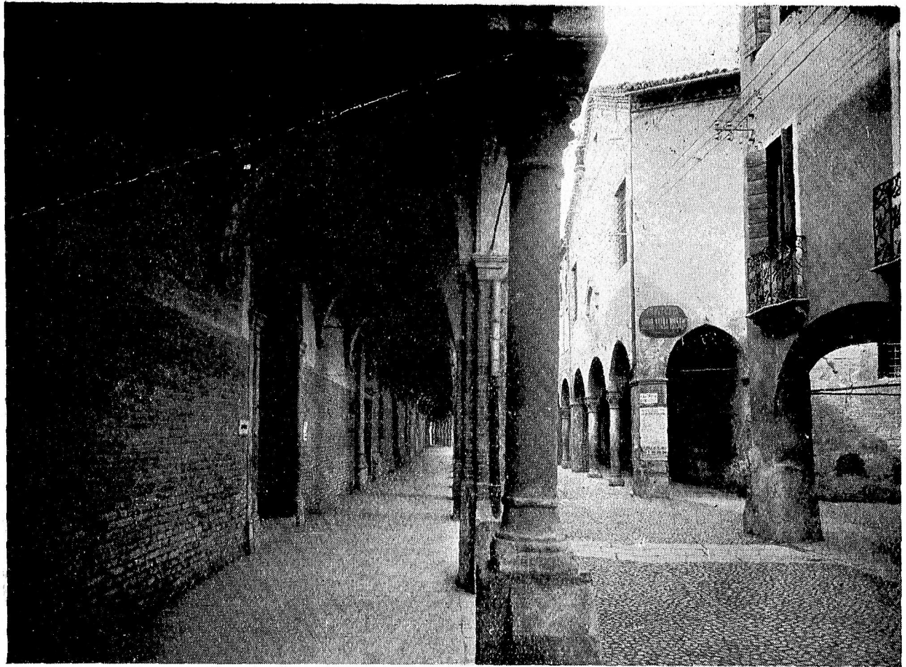
Il portico di S. Francesco dopo i restauri: a destra, la Scuola della Carità
