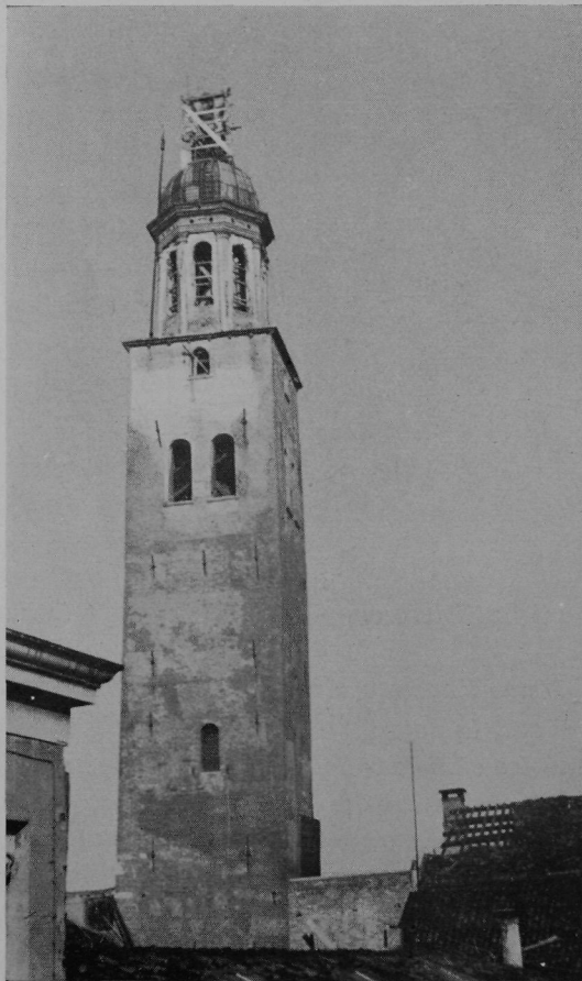
Si iniziano i lavori di demolizione
