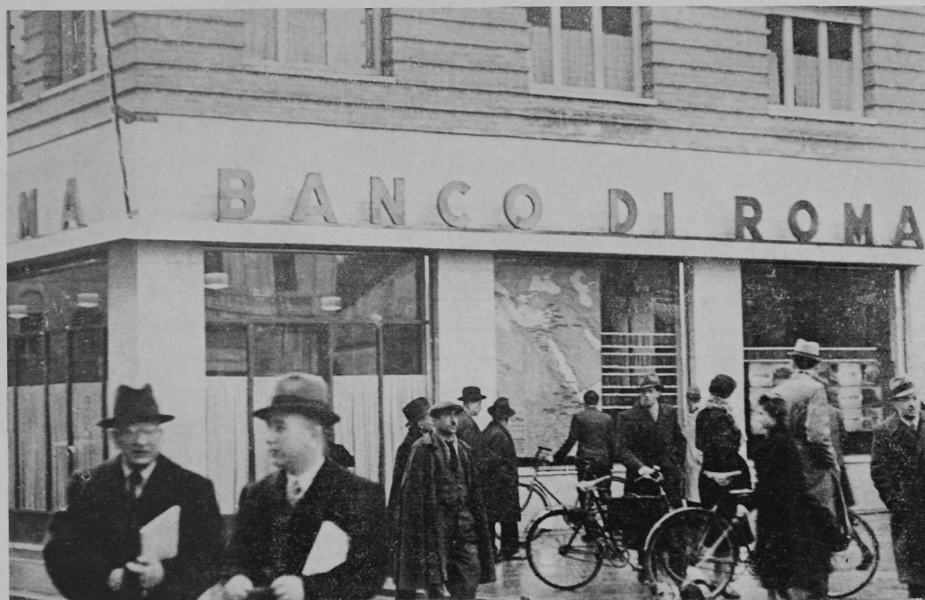
PADOVA - La filiale del Banco di Roma (Piazza Spalato - Angolo Via Oriani)
