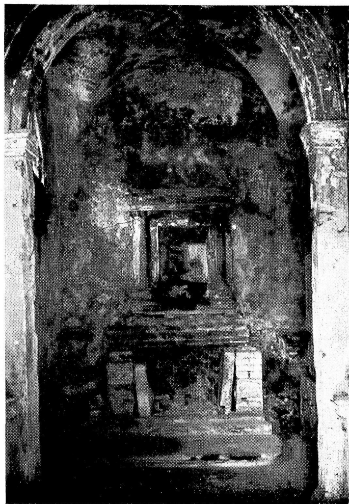
Il presbiterio prima dei lavori di restauro
