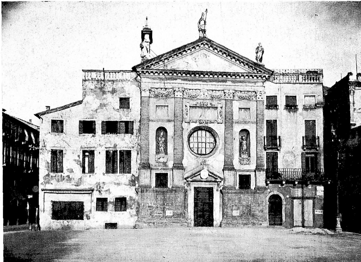
La Chiesa di S. Clemente prima dei restauri
