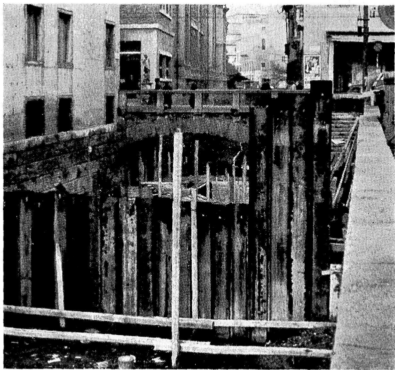
Lavori per la copertura del Naviglio a Ponte S. Lorenzo
