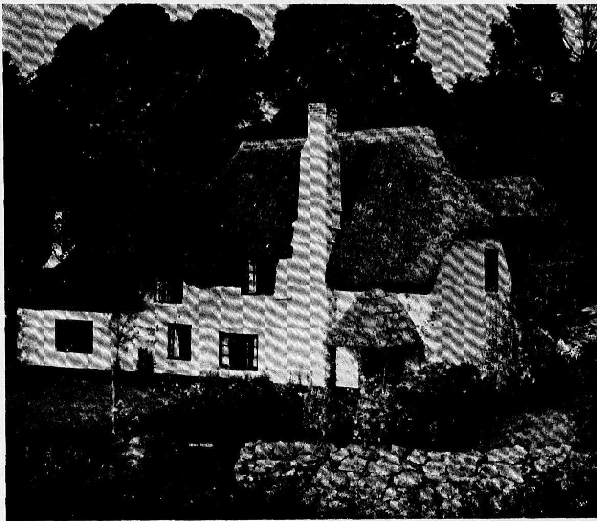
Casa rurale con tetto di paglia, nel Devonshire
