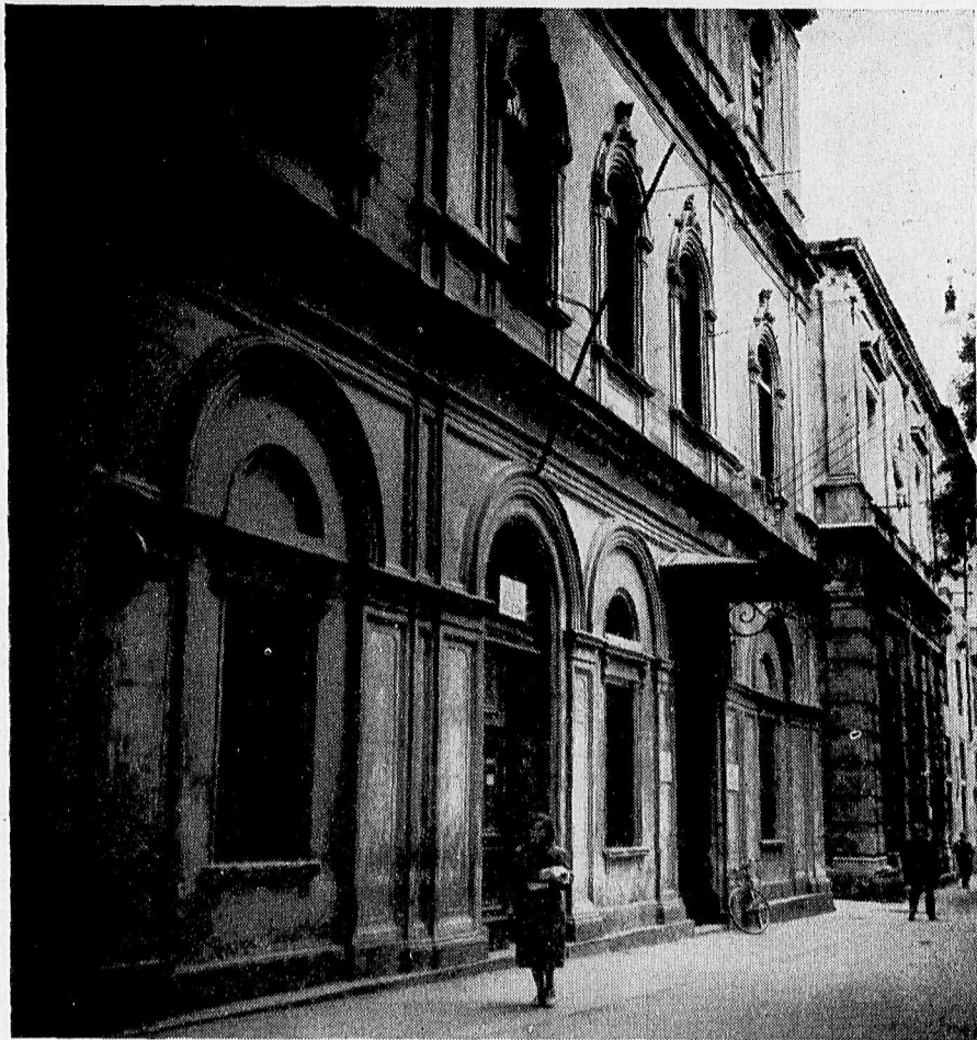
Piazza Capitaniato - L'ingresso agli uffici servizi demografici comunali
