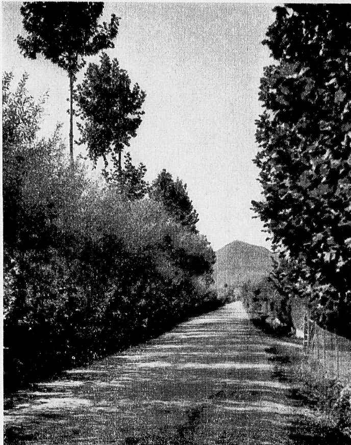
L'antica « Strada Romana » è stata asfaltata fino a Montegrotto. Ma la sua larghezza rimane decisamente insufficiente per il traffico veloce in continuo aumento
