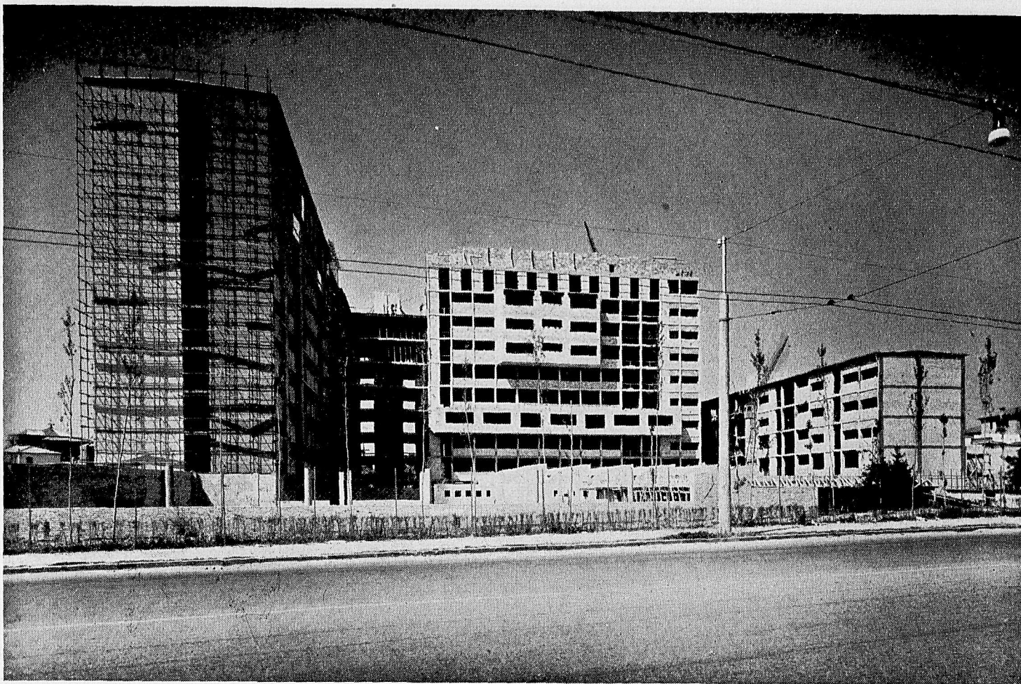
Facciata ad Est del «Blocco Policlinico»
