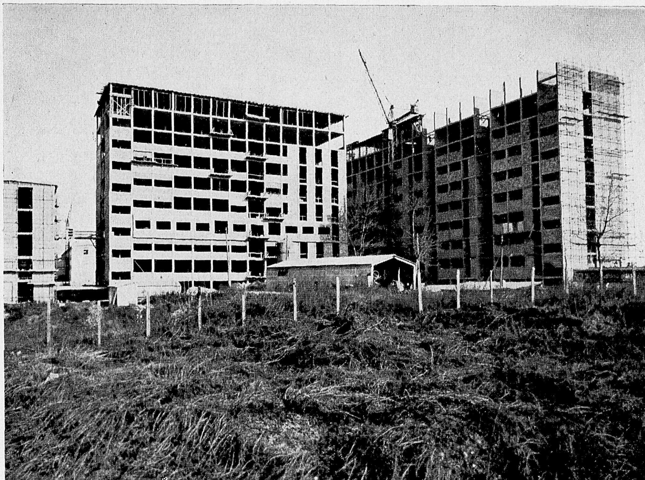
Veduta del fianco ovest in costruzione
