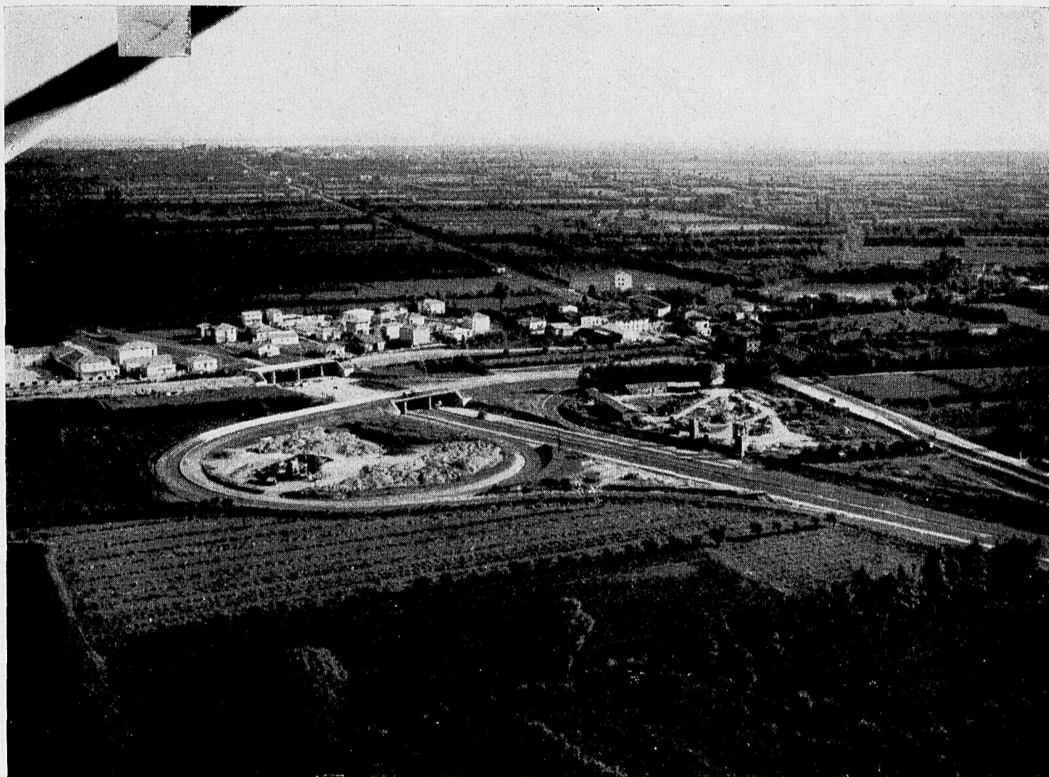
Autostrada Brescia-Padova, raccordo Brescia est
