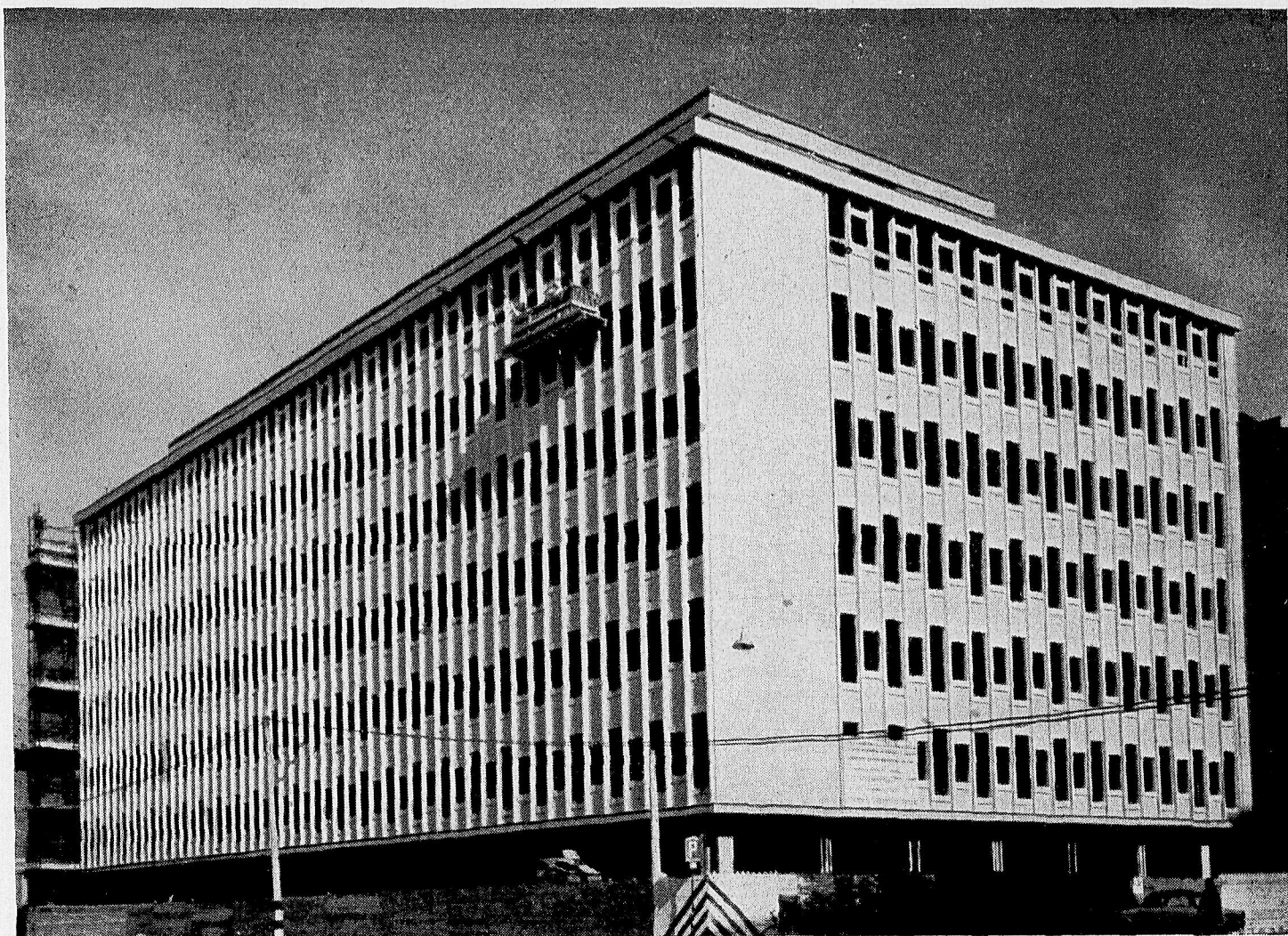
Edificio alle Porte Contarine
