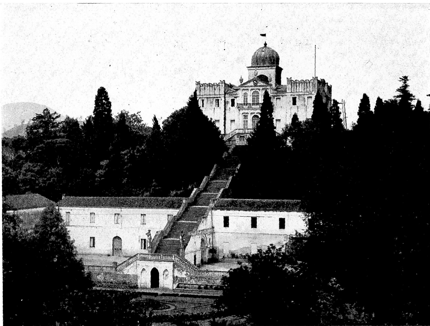
Battaglia Terme - Villa Selvatico, ora Emo, veduta da Levante con lo scalone secentesco e la sistemazione jappelliana
