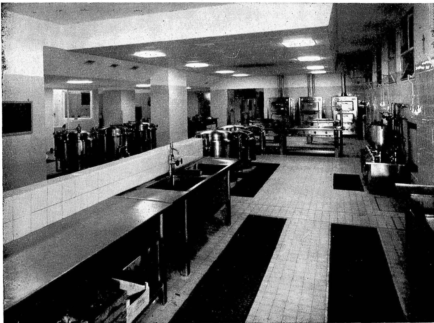
CUCINA DEL CENTRO TRAUMATOLOGICO I.N.A.I.L. DI PADOVA
