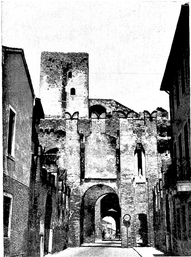
CITTADELLA - Porta Eassano con il torrione, reso accessibile da una scala in legno, dopo i recenti lavori di restauro. (Fotografie dell'Archivio della Soprintendenza ai Monumenti di Venezia)
