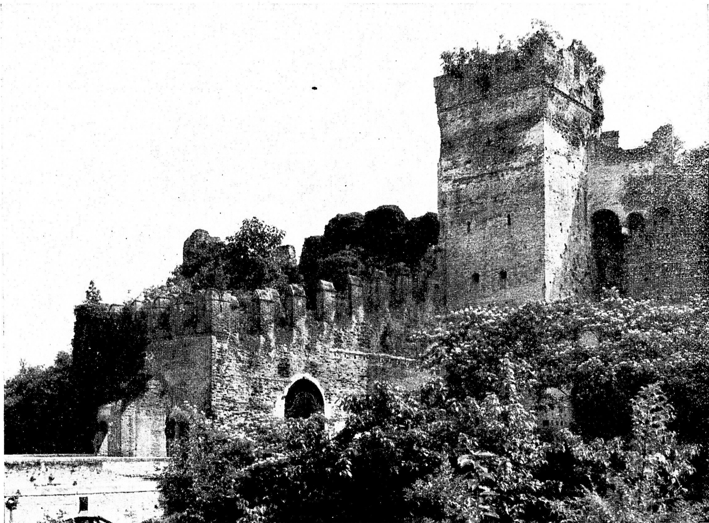
CITTADELLA — Porta Vicenza prima dei lavori di restauro eseguiti a cura della Soprintendenza ai Monumenti di Venezia.
