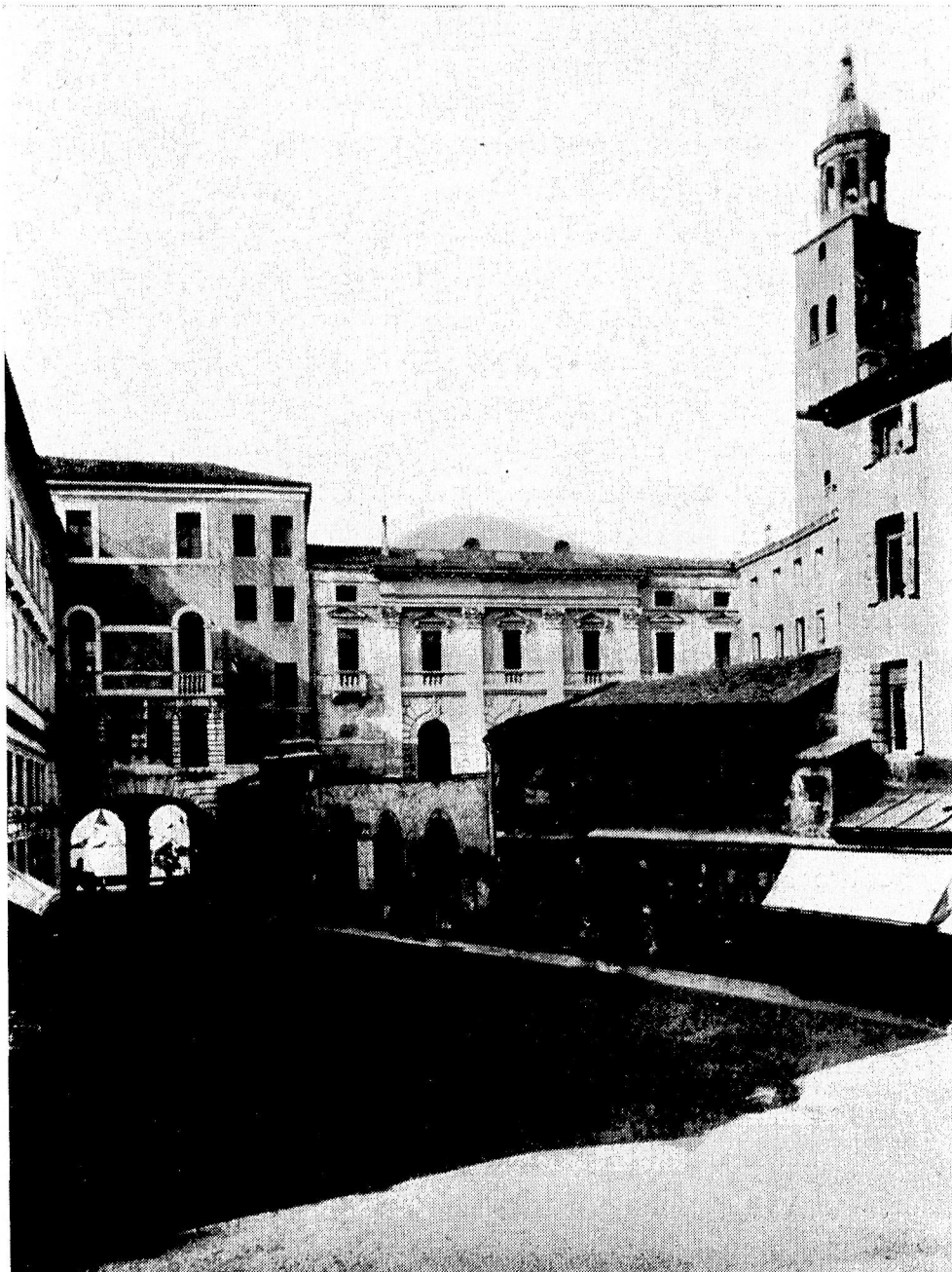
Fig. 5 - La facciata del Palazzo del Podestà era visibile, ai primi del '900 dall'angolo dell'Università. Le basse casette davanti sono antiche. A destra, si intravedono le alte case dell'800 (foto del Museo Civico)
