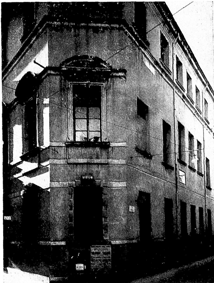
Padova. Palazzo Cumani, particolare dello spigolo N.E. (Foto Lux, Padova)
