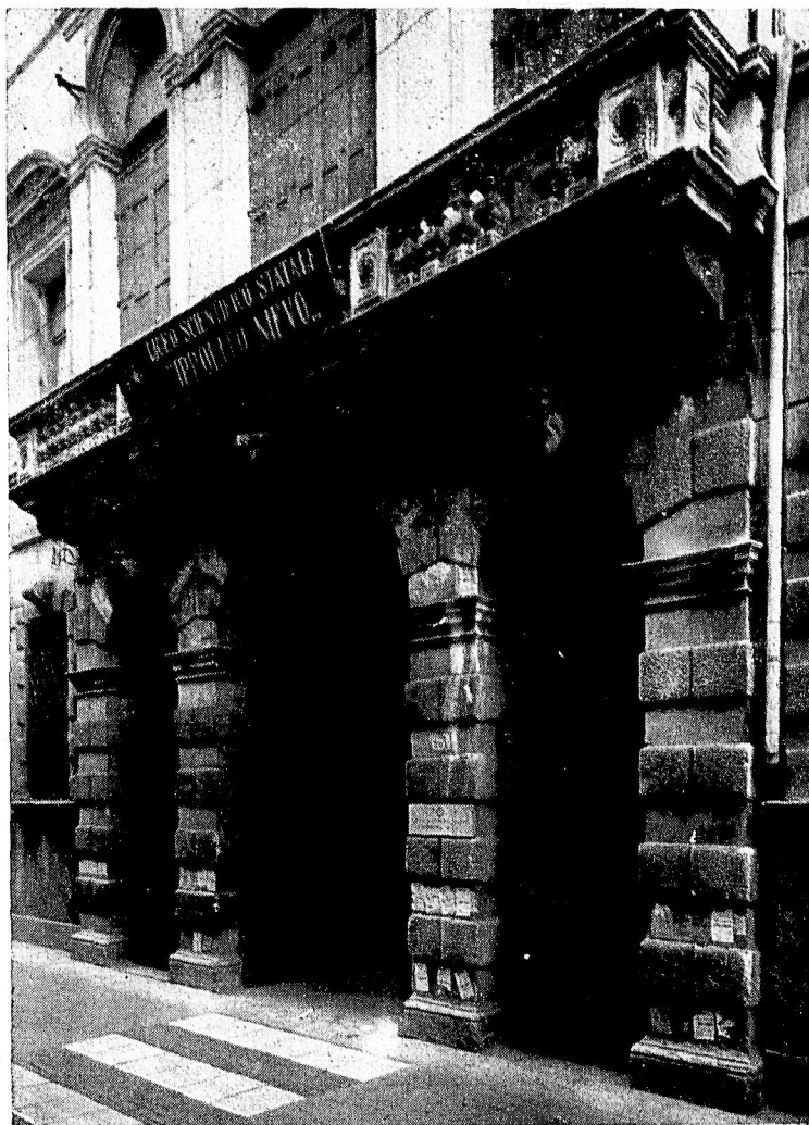
Padova, Palazzo Cumani, particolare dell'ingresso.
