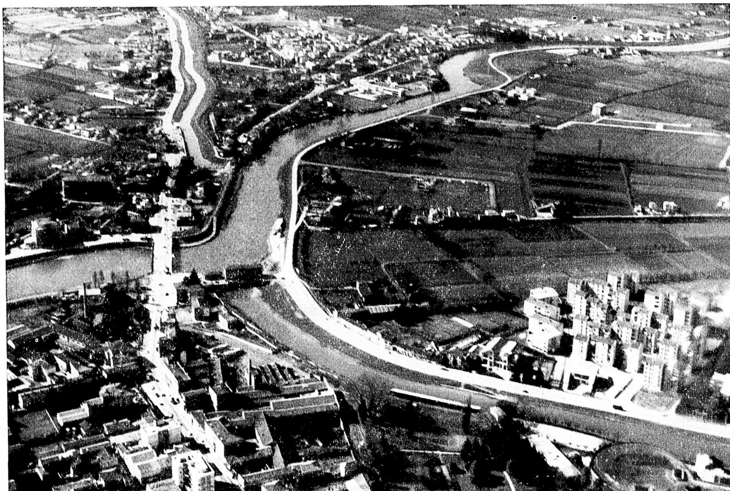
Padova - Visione aerea del Porto del Bassanello, sul fiume Bacchiglione, che ha visto il flusso e riflusso di migliaia e migliaia di passeggeri giunti da Venezia o diretti alla Città dei Dogi con il «Burchiello» (Foto Borlui - Venezia).
