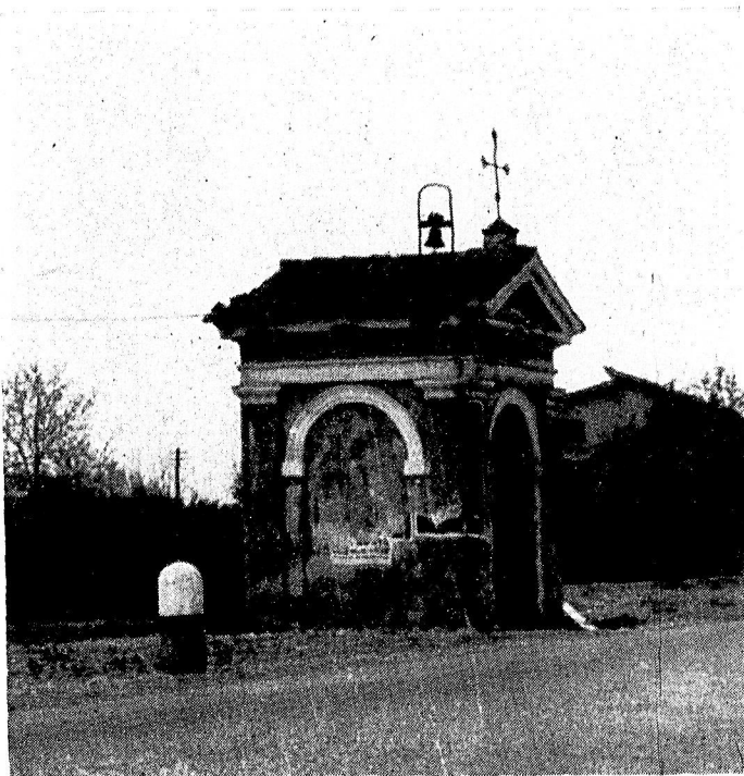
Vaccarino - Capitello demolito per dare spazio alla strada.
