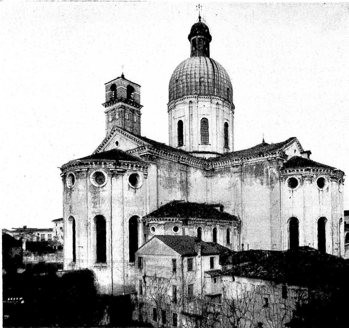
Padova - Duomo, parte absidale. (Foto Lux - Padova)
