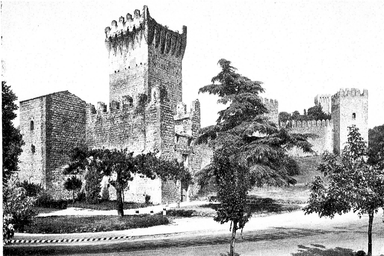
Este - Il Castello dei Carraresi visto da nord
