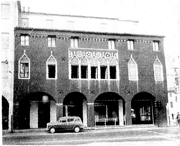
Casa in via Belzoni (ricostruita con avanzi golici)
