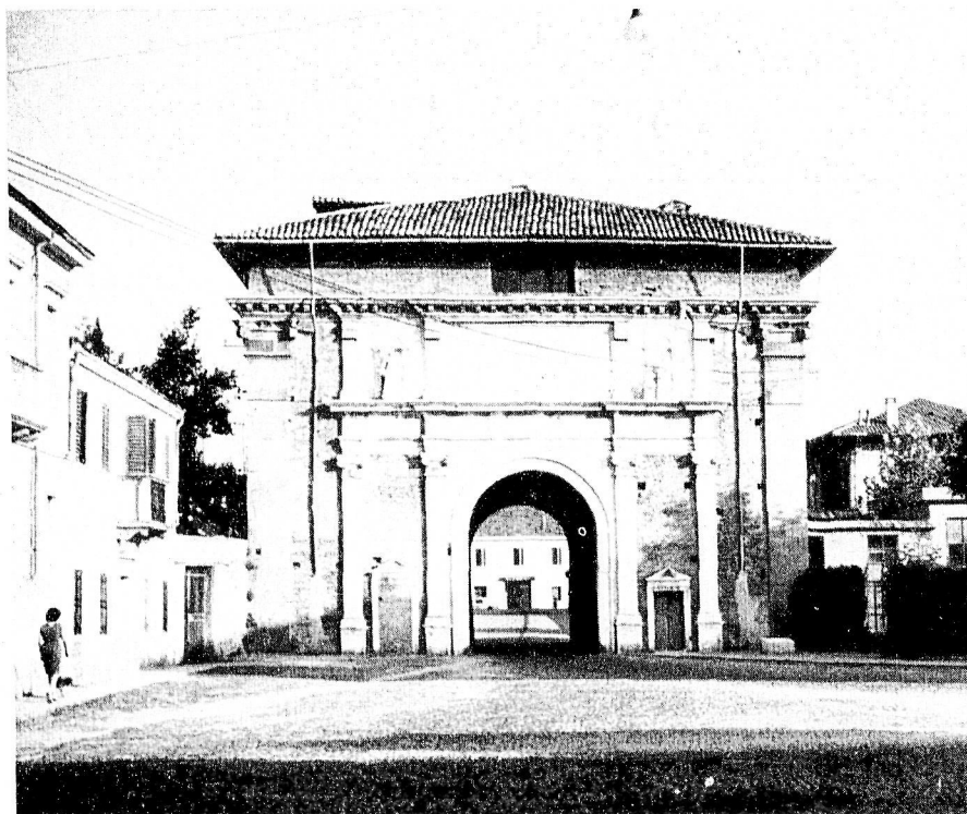
PADOVA - PORTA S. Croce - Prospetto Nord-Ovest — costruita nel 1527. E' sormontata dalle statue dei santi Prodocimo e Girolamo. (Foto Scorzon)
