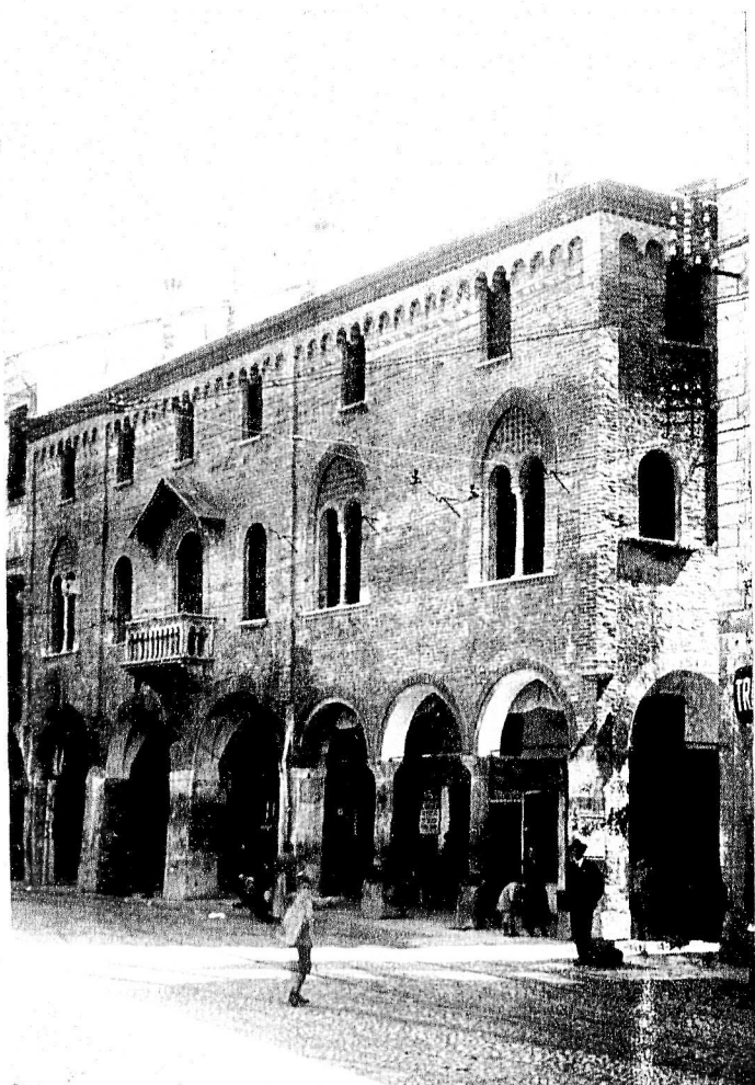
Casa Bonaffari in Piazza Duomo Facciata
