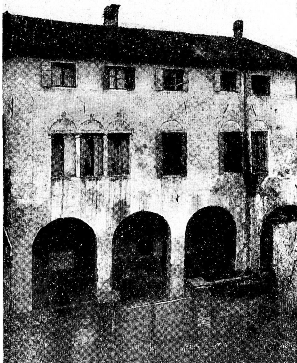
Casa Buzzaccarini in via Borromeo (ex casa del Fico)
