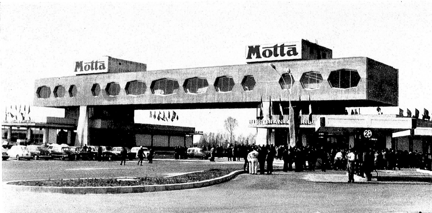
LIMENA - PADOVA — Visione d'insieme del «Mottagrill», imponente costruzione «a ponte» sull'Autostrada della Serenissima. I due saloni a pianoterra ospitano i servizi di bar e di vendita self-service dei prodotti, mentre il «ponte» ospita il Ristorante per 300 persone e il Ristorante self-service con relative cucine. (Foto F. Zambon - E.P.T. Padova)
