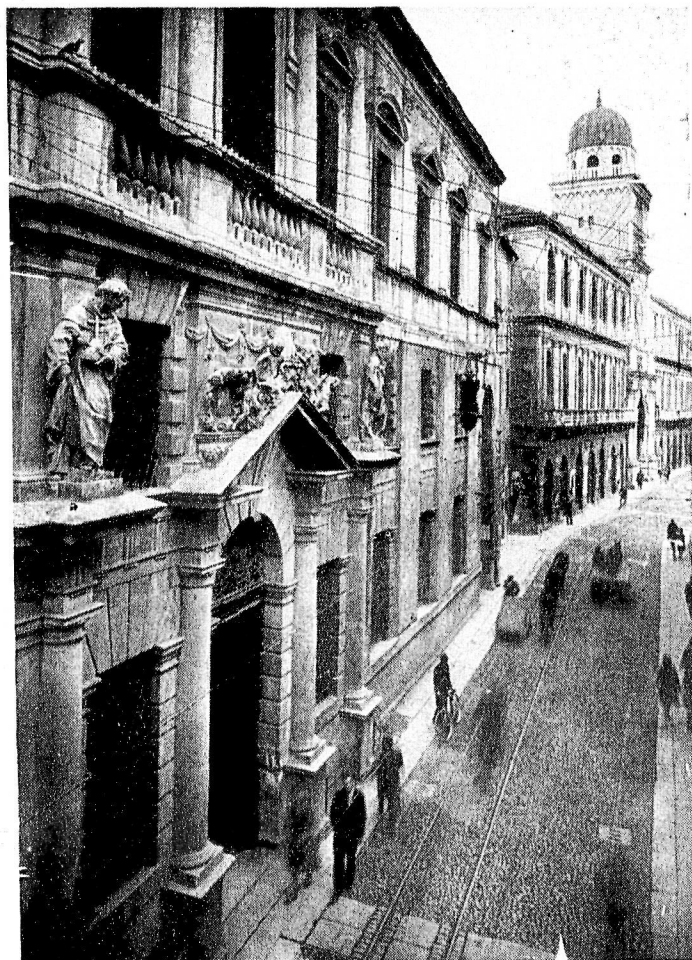
Facciata orientale del Monte di Pietà.
