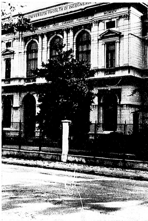
8 - Scuola Appl. per Ingegneri (fronte via Loredan).
