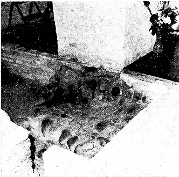
1 - Fondazioni di un precedente edificio (parte sinistra)
