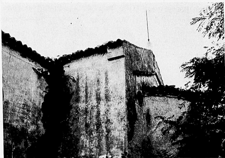
Monselice: chiesa di San Tommaso. Il particolare evidenzia la pianta a croce latina dell'edificio (a cui è aggregata una navatella-sacrestia sul lato sinistro) e l'abside, con una interessante cornice in cotto di sapore romanico, un piccolo foro oblungo che si rifà al Seicento e tracce di un innalzamento della navata centrale. (foto: F. Sabbion)
