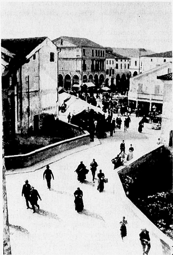
8 - Il ponte Transalgarde
