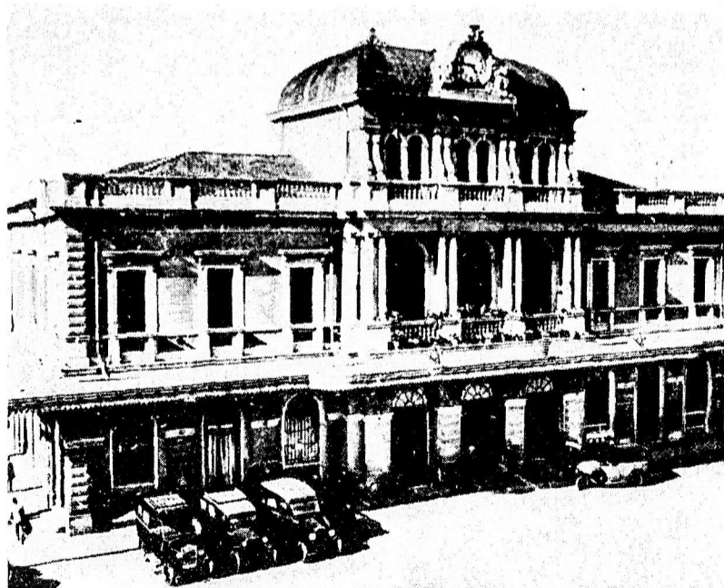
Padova tra Ottocento e Novecento: la Stazione Ferroviaria.
