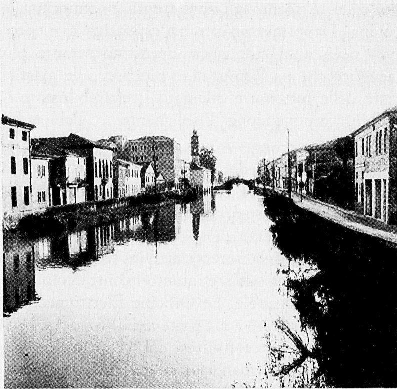
Il centro storico di Battaglia tagliato dal rettilineo canale, scavato nel Duecento e attorno alle cui rive è nato e si è sviluppato l'abitato.
