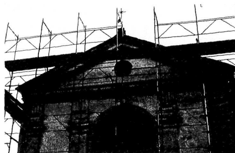
Chiesa di S. Massimo in Padova: lavori di restauro alla facciata.
